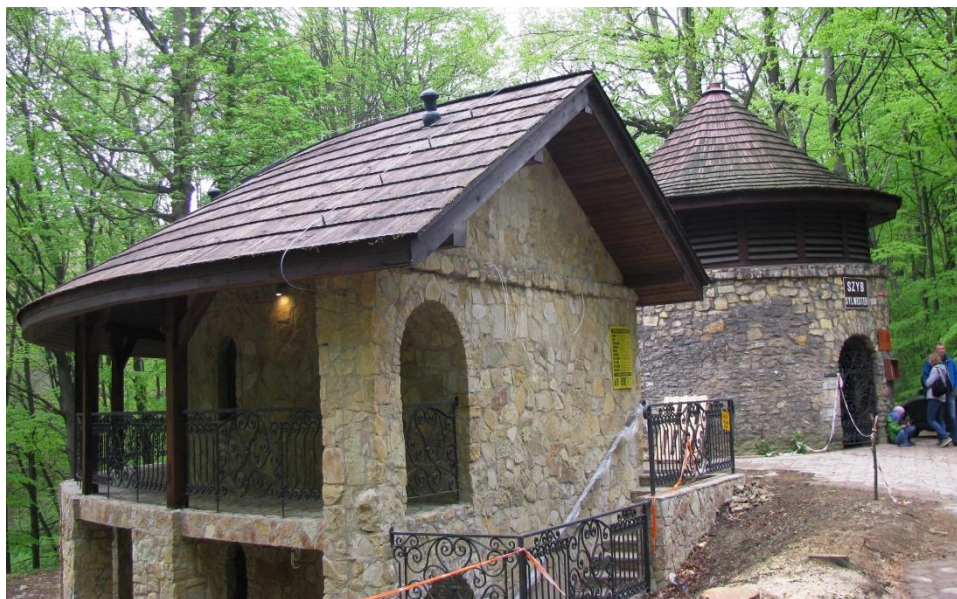
Ryc. 5. Szyb Sylwester i powstający budynek edukacyjny
