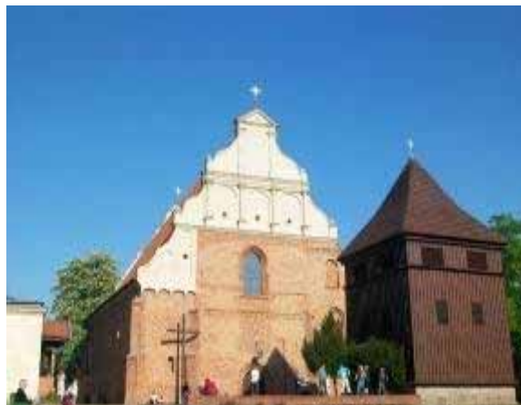
Fot. 14. Fasada kościoła św. Wojciecha z drewnianą dzwonnica (fot. K. S.)
