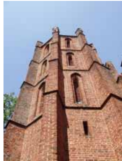
Foto 2. Wieża kościoła w Lembargu, ujęcie od pd.
