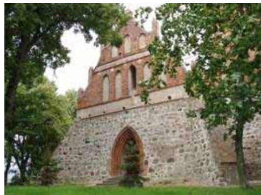
Foto 3. Zachodnia elewacja kościoła w Wabczu.
