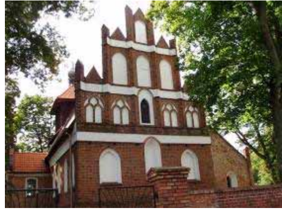
Foto 24. Wschodnia elewacja kościoła w Radowiskach Wielkich.
