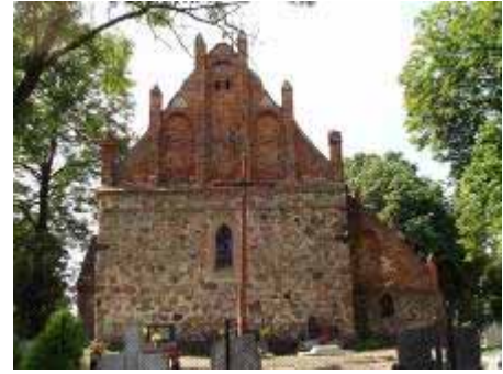
Foto 15. Harmonijna elewacja wsch. kościoła w Brudzawach.
