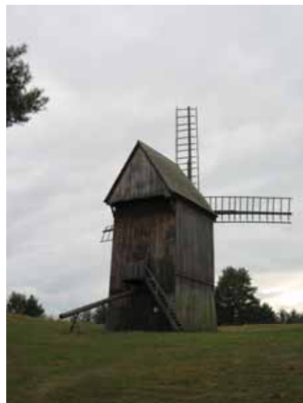
Fot. 4. Wiatrak koźlak z Wielkopolskiego Parku Etnograficznego, widok od strony ściany frontowej z wejściem (fot. I. Wyszowska).
